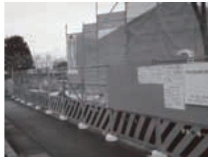
いちいの里（すばる）工事現場
