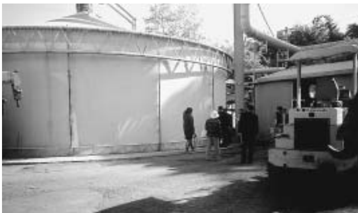
燃やさない焼却炉リダクションプラント（生ゴミ分解処理装置）
