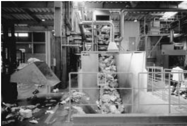
受入供給コンベヤ 搬入された容器包装プラスチックゴミを受け入れる
