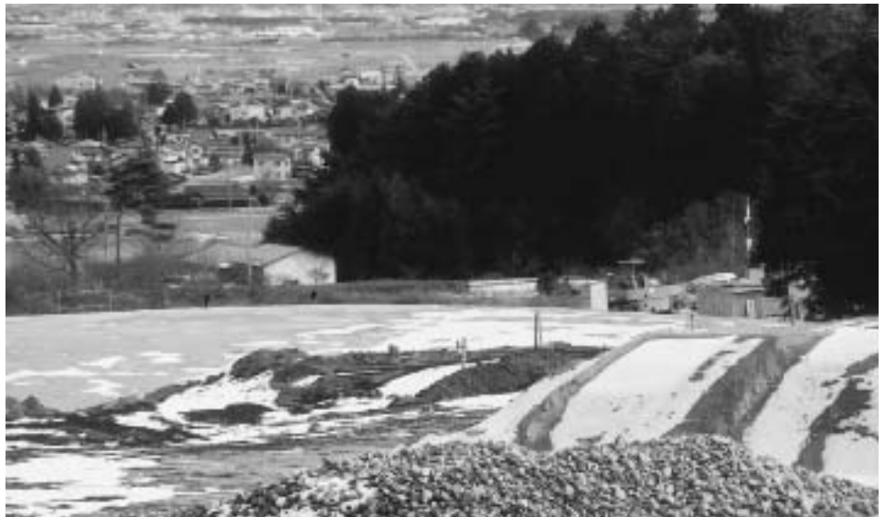
工事が進む墓地公園予定地
