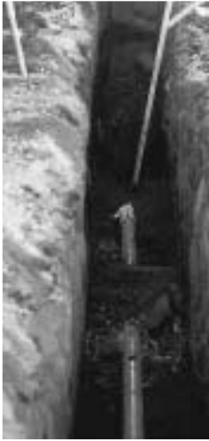
布設替えされてい る本管 (大池原にて)
