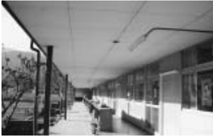
▶ 保育園ベランダの天井
