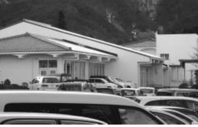
煙突を取り除いてすっきりした小学校南校舎の屋根
