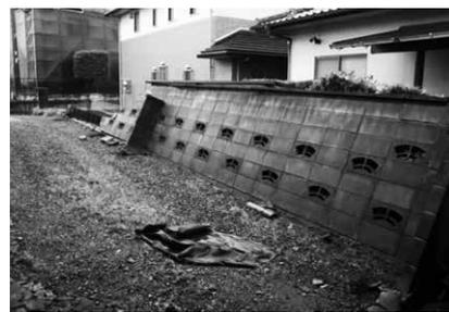
基準に適合せず転倒したブロック塀
