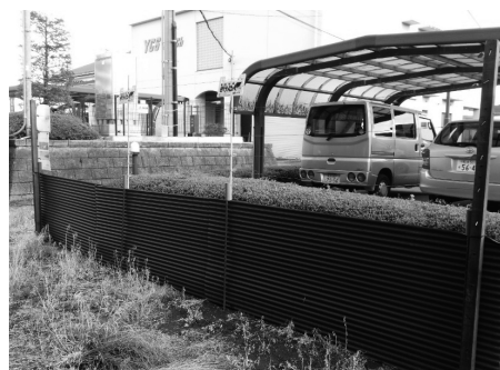
電気柵とトタン板を組み合わせた例 (役場庁舎南側でサンプル展示中)
