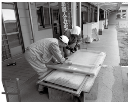
▲山形保育園 網戸の修繕
