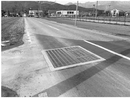
②【完了区間】水路兼用道路を流れてくる水を集水する排水柵が設置されました
