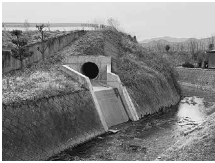
①【完了区間】三間沢川へ排水する敷設管の末端部
