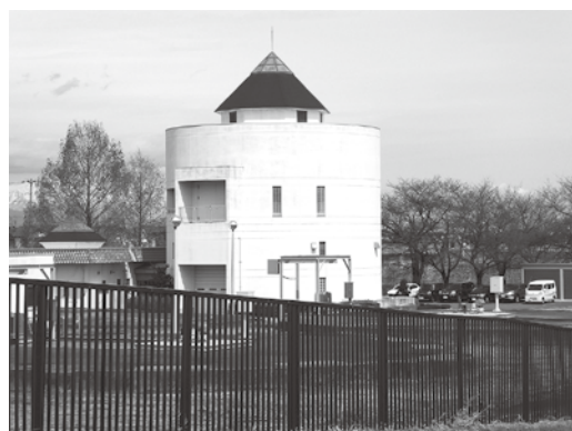
ウォーターパル (下水道処理施設)
