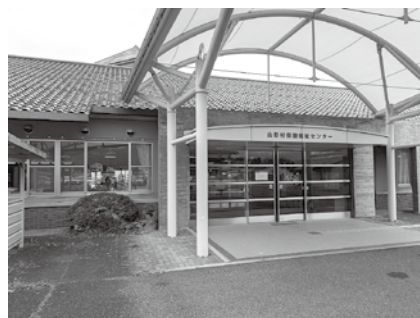
災害時利用者が制限される福祉避難所
