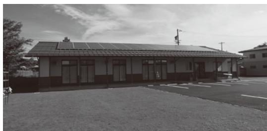
下竹田防災拠点施設
