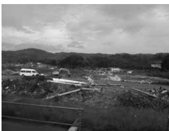
東日本大震災で倒れた信号機、電柱の状態
