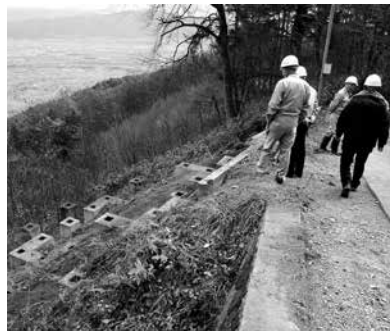
〈清水寺展望台を解体〉
