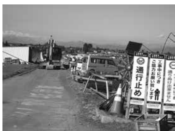
県営大池原・東原地区 排水工事真っ最中
